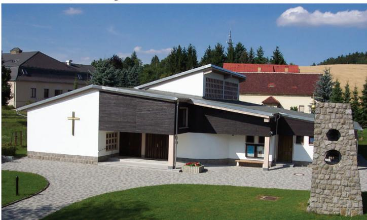
Abb. 7: Sonderform: Kombination aus flachgeneigtem Schlep- und Pultdach, Oppach
