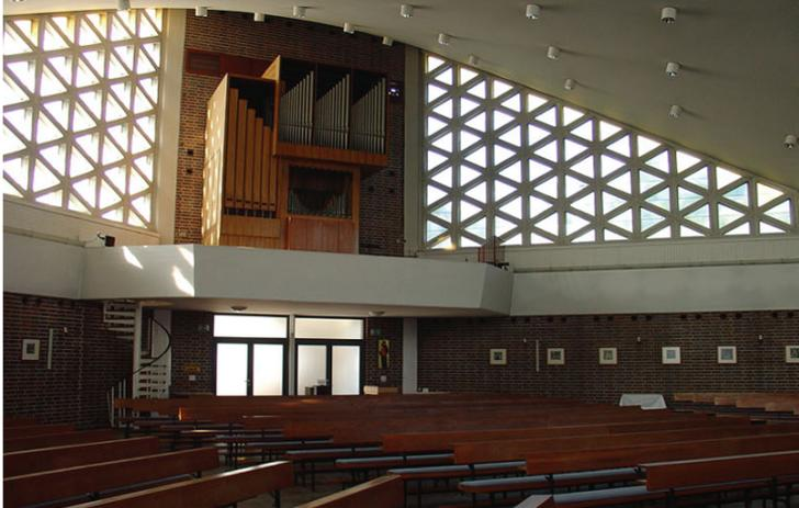
Abb. 5: Sonderform: große Glasflächen durch Betonraster unterteilt, Rostock
