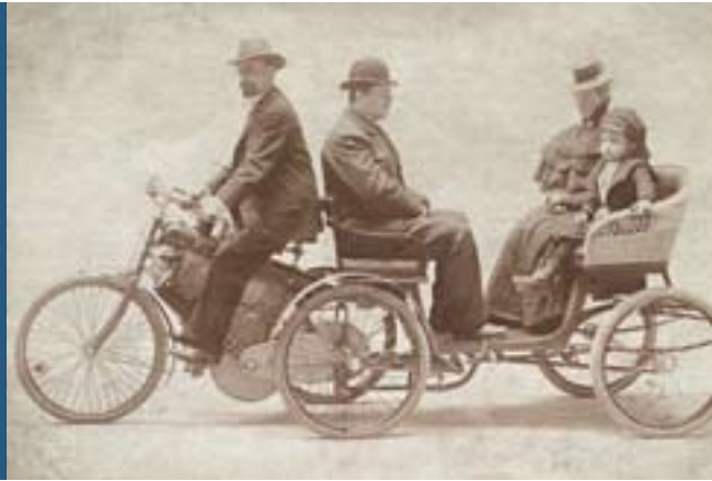
Bild rechts: Für Fahrzeuge wie dieses Dreirad von Heine & Wegelin mit Rücksitz und Anhänger entwickelte Bosch ein Magnetzündsystem, 1897.
